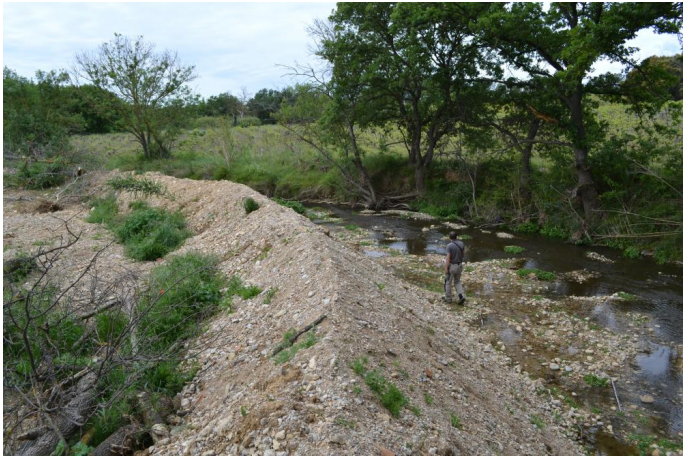
Retalutage des berges (plantation et restauration de berges à prévoir), le 03/05/2017 par Jérémy Cuvelier.
